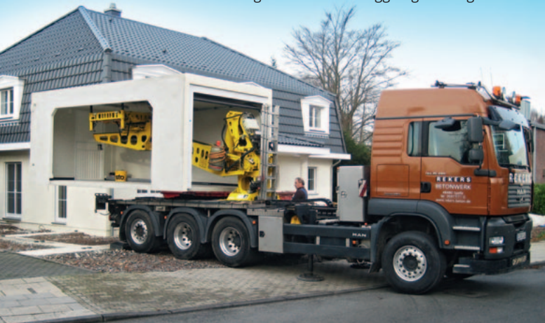
Anlieferung einer Beton-Fertigarage mit eigenem Lkw
